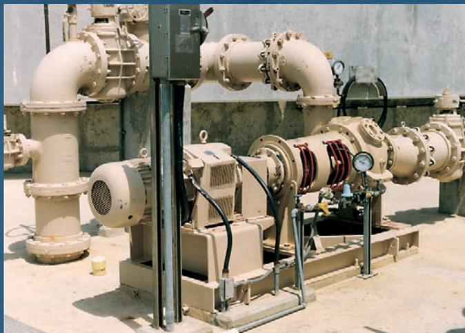
Morris 7100 – это серия больших насосов для сухой установки, предназначенных для отведения сточных вод, включая канализационные, для перекачки необработанных вод с содержанием твердых частиц. Прочные материалы, высококачественное литье и профессиональное проектирование обеспечат вам продолжительный срок службы и эффективную работу при отсутствии вибрации.
